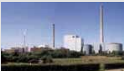
The CHP plant Fynsværket in Denmark (Elsam kraft)
